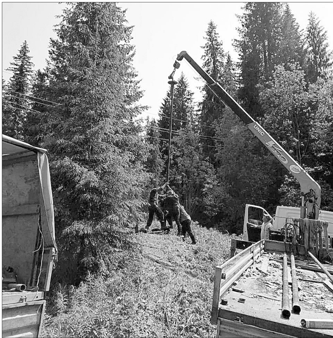
Установка насоса на новую скважину в Кусье.
