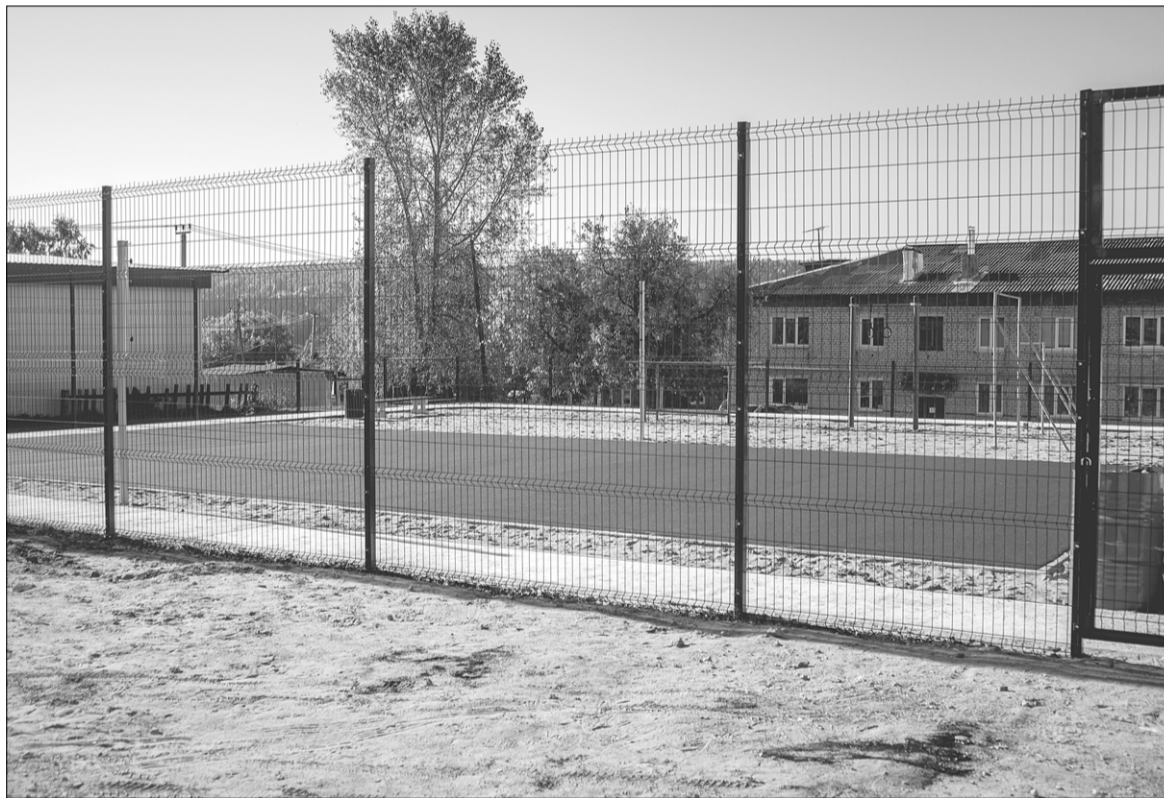
В скором времени на площадке Пашии появится оборудование.
