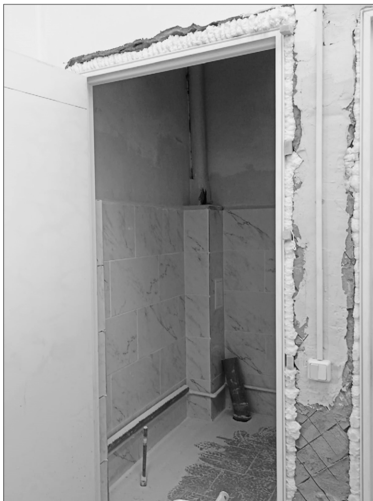
После ремонта уборные помещения ДК станут современными.
